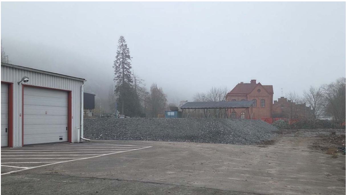
Bild 4. Vid undersökningstillfället hade markarbeten påbörjats inom den sydöstra delen av området. Marknivån hade höjts ca 2 meter med ett lager krossmaterial (GEO-gruppen AB, 2025).
